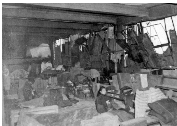
窓ガラスはなく降り込む雨や寒風で最悪の環境だったが、被爆者や家族はここを仮住居として生活していた。
