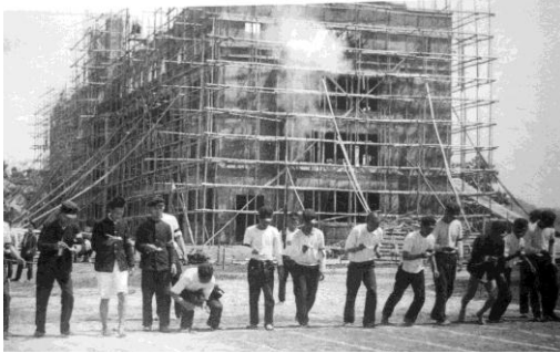
運動会の向こうで建設中の鎮西学院校舎
