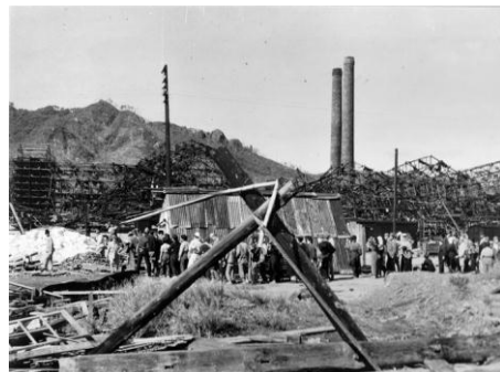
浦上駅のバラック仮設駅舎
