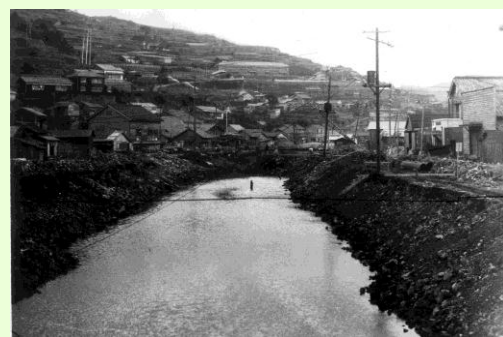
宝町付近の道路新設工事 (昭和25年12月 提供写真)
