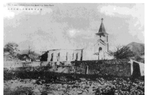
廃墟となった西中町天主堂
