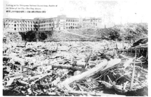
破壊された城山国民学校の校舎
