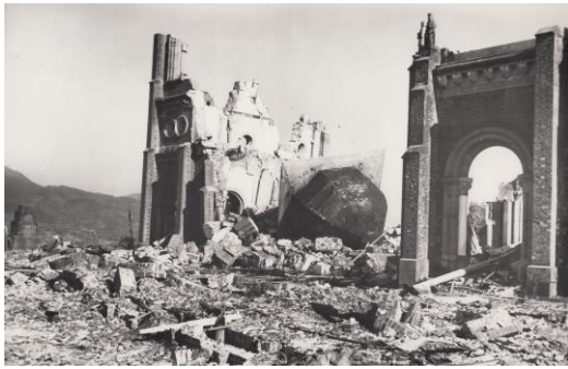
中央に崩落した鐘楼が見える
